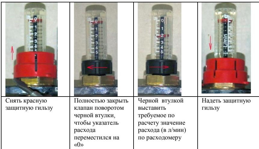
Снять красную защитную гильзу
