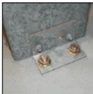
Крепление самонесущих конструкций
